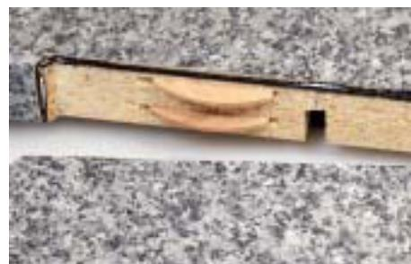
**3/** Weil die Dichtmasse schnell aushärtet, müssen die Arbeitsplatten sofort zusammengefügt und verschraubt werden. Es ist daher ratsam, nötiges Zubehör wie Verbinder oder Flachdübel vorher schon bereitzulegen.
