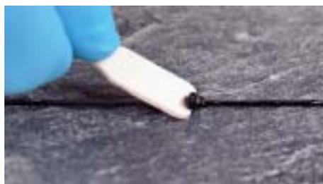
**5/** Sofort reinigen – Hautbindezeit nur ca. 20 Minuten. Die evtl. austretende, überschüssige Menge sollte am besten im ersten Schritt mit einem Holzspatel entfernt werden. Im nächsten Schritt werden die ...
