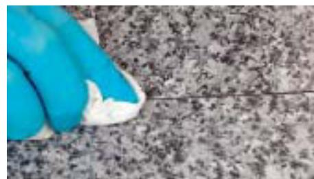
**6/** ... Reste mit oberflächenverträglichem Reinigungsmittel entfernt. Die ausgehärtete Fuge ist hoch alterungsbeständig, trotz Wasser, Fetten sowie Reinigungsmitteln und kann bei Bedarf sogar überlackiert werden.
