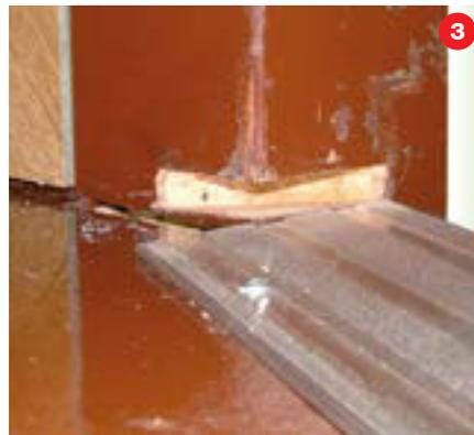
**Hinweis:** Zur Vorbereitung/Anpassung der Stufen kann ein Glassauger zur besseren Handhabung verwendet werden.
